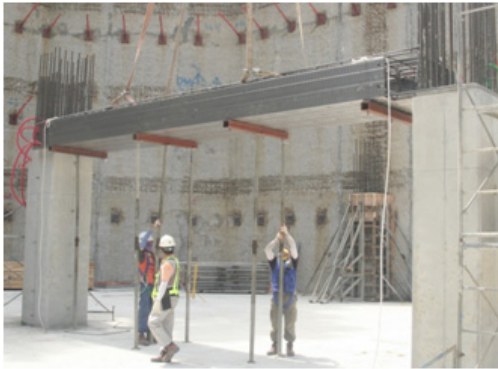
Fig. 3 Erection of DH beam
