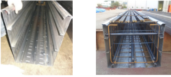
Fig. 1 DH plate and rebars
